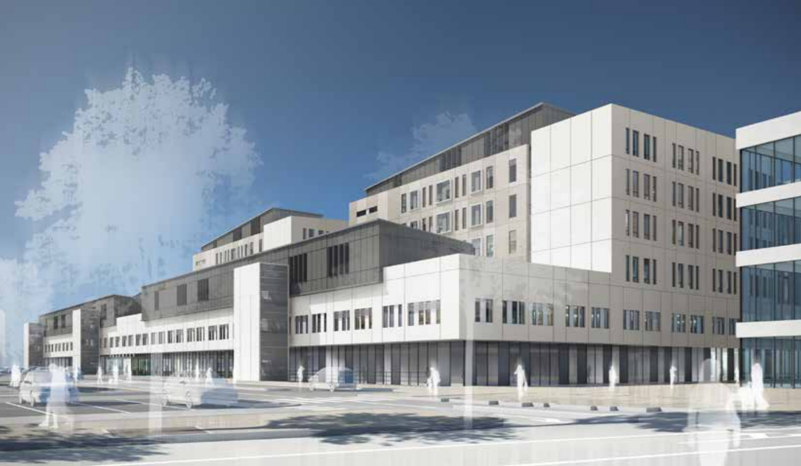
708 lits, 26 m de haut, 170 m de long , 80 m de large, sept niveaux. Surface : 60 000 m 2
